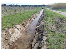
Fossé (domaine INRAE Pech Rouge) pour une expérimentation « in situ » de l'effet tampon en condition d'écoulement
