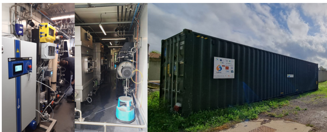
Fig. 1 : Pilote installé sur la station de traitement des eaux usées (STEU) de St-André de Sangonis [34]
